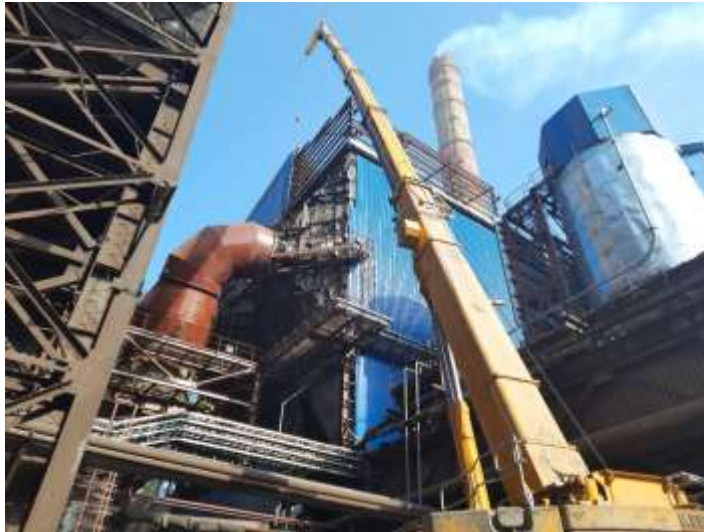
Установка электрофильтра на Агломашине №5
